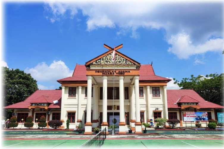
Gambar 4.1. Gedung Kantor Pengadilan Agama Muara Tebo
